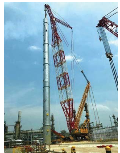
シンガポールの現場でタワーを吊り上げる世界最大級のLBCであるCC 8800-1
