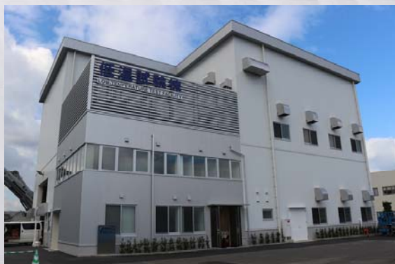
低温試験棟 外観
