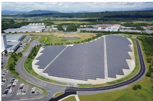
2013年に稼働した 滋賀事業所のメガソーラー
