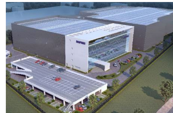
半導体・液晶生産ライン向けシステムの 工場（中国・蘇州）の屋根に太陽光 発電システムを設置予定（2023年）
