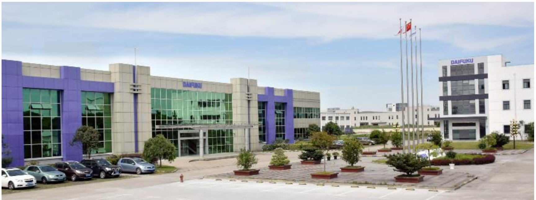
大福(中国)物流設備有限公司の新本社兼工場
