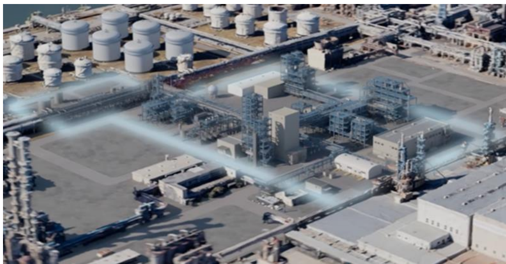
大型パイロット装置完成イメージ（青枠が該当装置）
