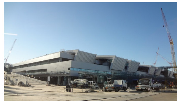
豊洲市場 水産仲卸売場棟 建設工事写真（H27年12月）
