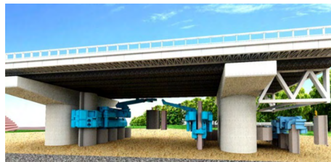
厳しい制約条件での橋脚補強技術
