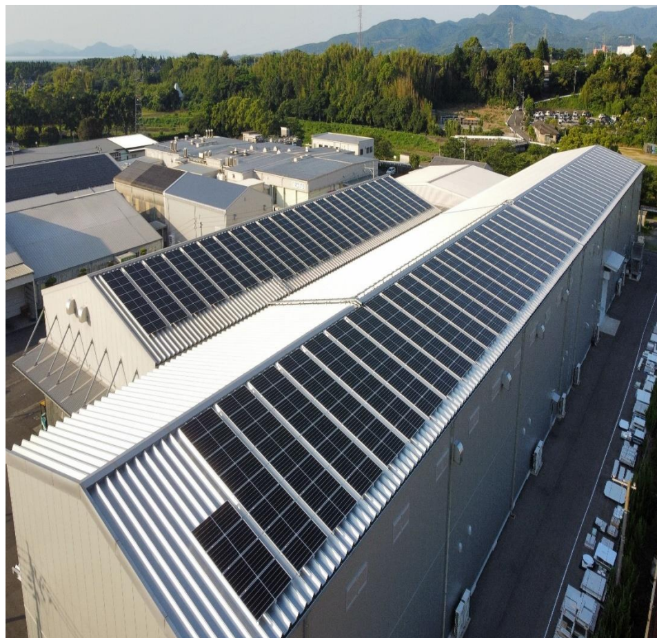
2021年6月高尾野事業所第4工場・第8工場 太陽光パネル設置の様子
