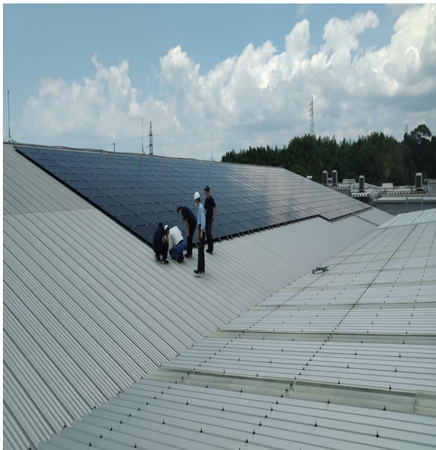
2020年6月高尾野事業所第2工場 太陽光パネル設置の様子
