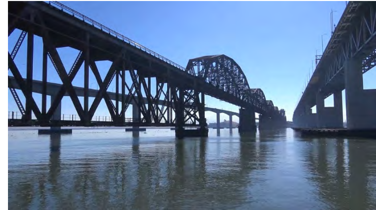
鉄骨造の橋梁点検等を実施(提供: オートモダリティ社)
