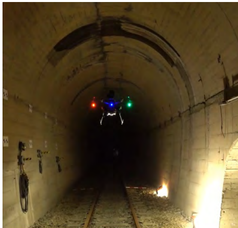
JR北海道 トンネル点検
