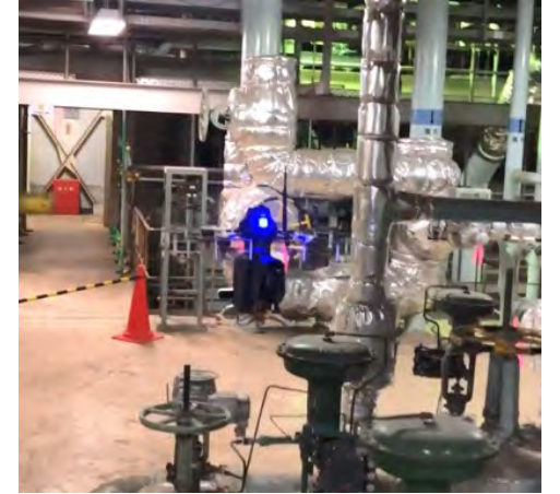
日本ユニシス 設備点検
