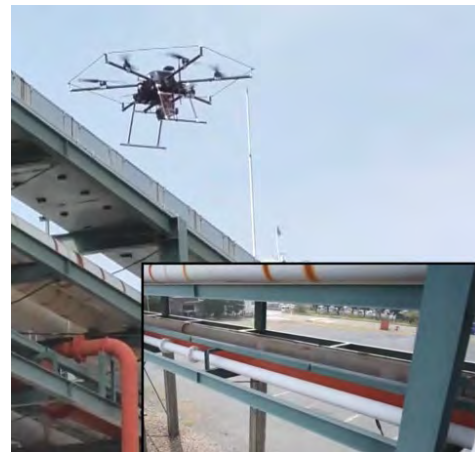
JSR 配管点検
