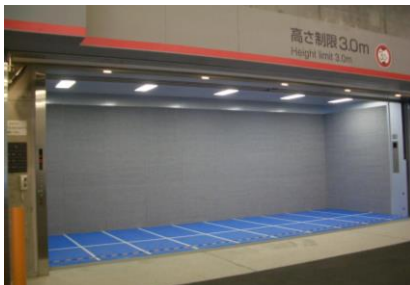
劇場ホール設置エレベーター (積載荷重7.7t)
