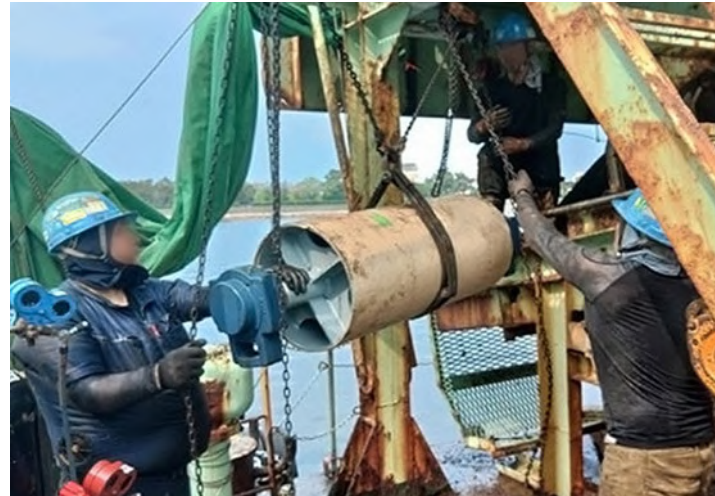
部品取付・交換・メンテナンス
