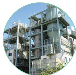
水処理施設 (下水・水再生センター)
