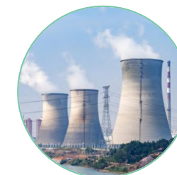
原子力 発電所
