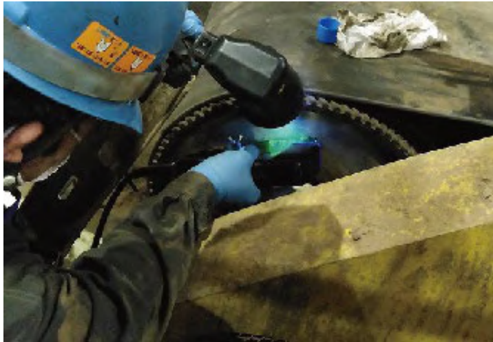
部品・設備の点検・診断
