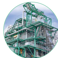
バイオマス 発電所
