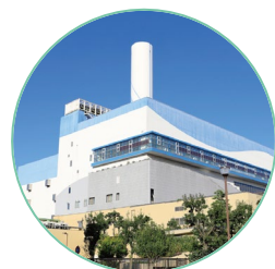
ごみ処理施設 (焼却・リサイクル)
