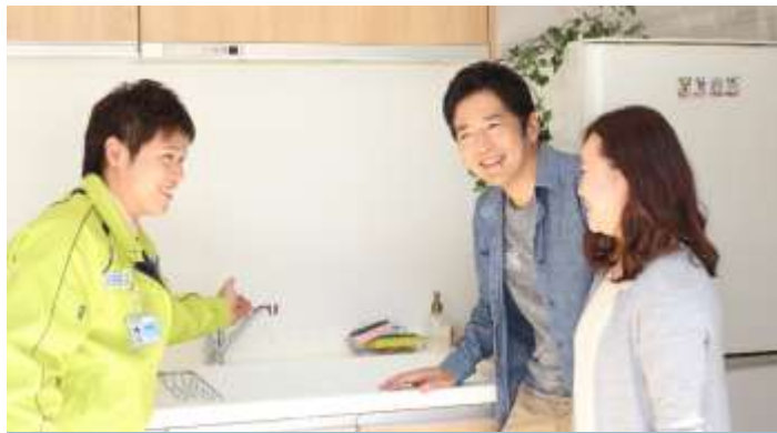
水まわり修理・取付工事
