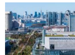
インフラ設備
