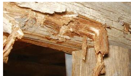
湿気被害により耐力が低下した接合部(左)、大引き(右)
