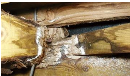
湿気被害により耐力が低下した接合部(左)、大引き(右)
