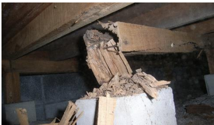
白蟻被害により耐力が低下した束柱(左)、大引き(右)
