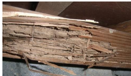
白蟻被害により耐力が低下した束柱(左)、大引き(右)
