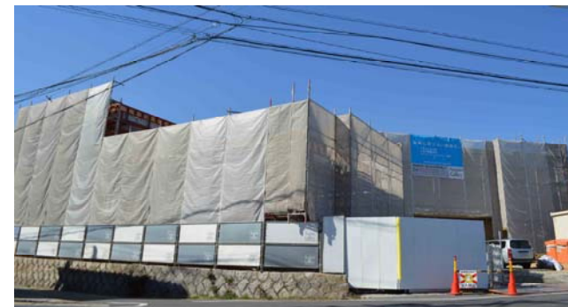
2016年2月12日現在 建設中
