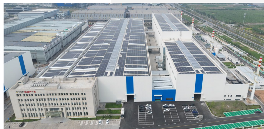
GDF 広州新工場 (竣工、稼働中)
