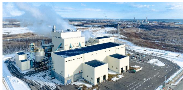
バイオマス発電プラント
