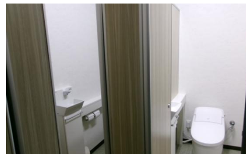
トイレの改修
