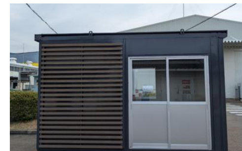
従業員用休憩ブースの新設
