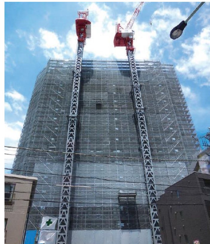
高さ80mのタワーマンション B2階からの立ち上がりの足場部分は最高高さ90m
