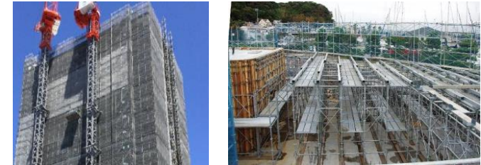
進化する足場「アルバトロス」
