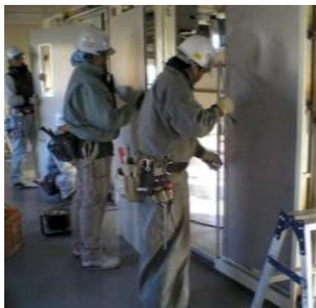
シャッター及びドアの施工研修の様子
