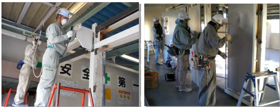
シャッター及びドアの施工研修の様子
