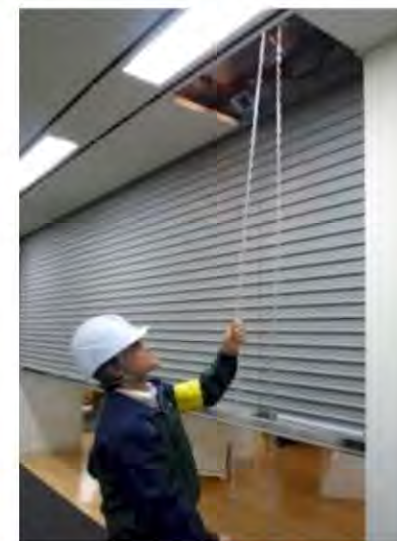
保守点検の様子
