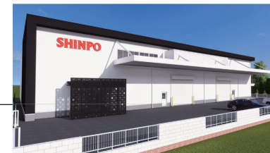
2025/4 名古屋アミ工場稼働予定
