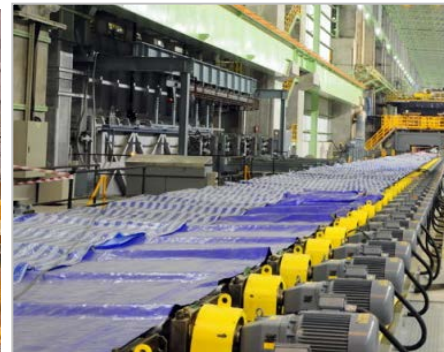
建設中の熱間圧延機
