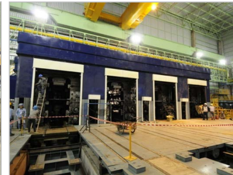
建設中の4スタンド 仕上圧延機
