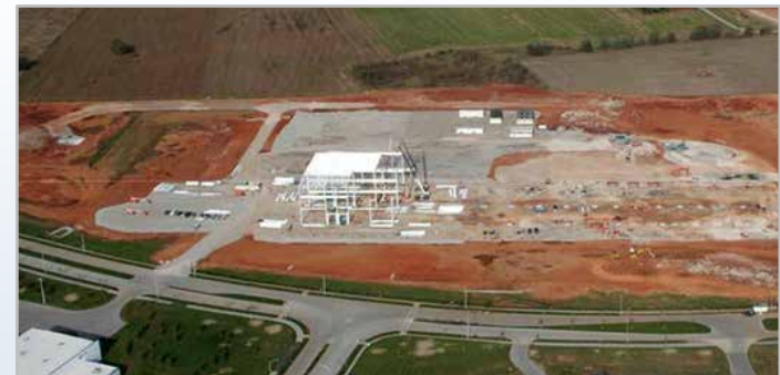
順調に建設が進んでいる新工場
