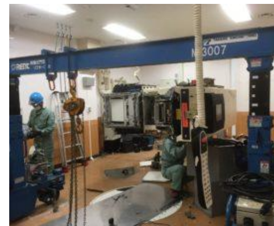
【屋内での解体作業状況】
