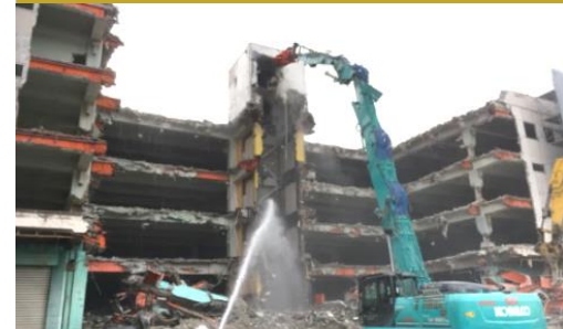
鉄筋コンクリート造解体
