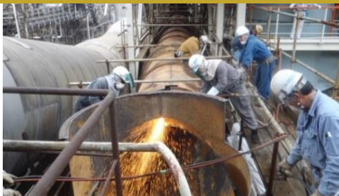
プラント ガス解体
