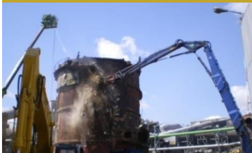
プラント 重機解体
