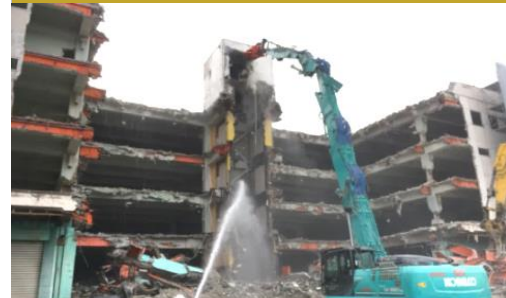
鉄筋コンクリート造解体
