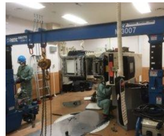
【屋内での解体作業状況】
