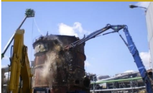
プラント 重機解体
