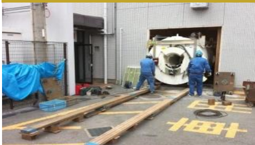
壁面切断・MRI撤去
