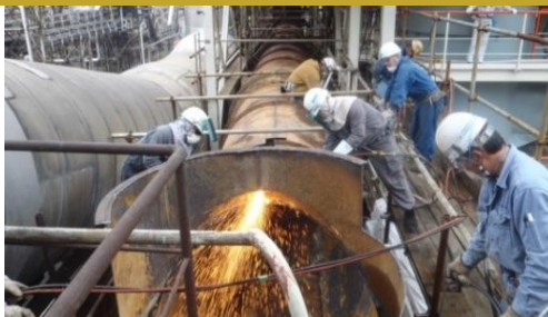
プラント ガス解体
