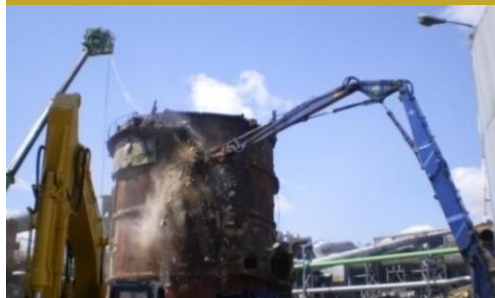
プラント 重機解体
