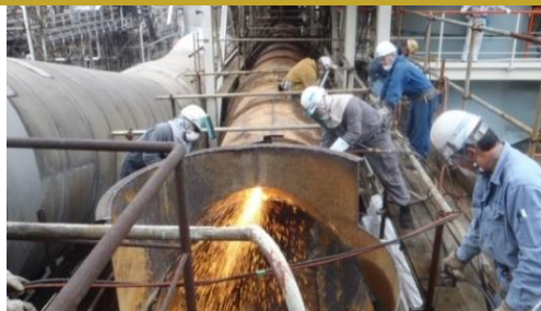
プラント ガス解体
