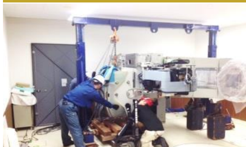
リニアック解体搬出
