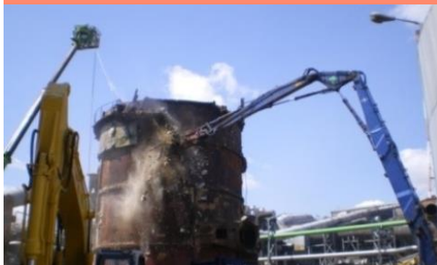
プラント 重機解体
