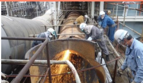
プラント ガス解体
