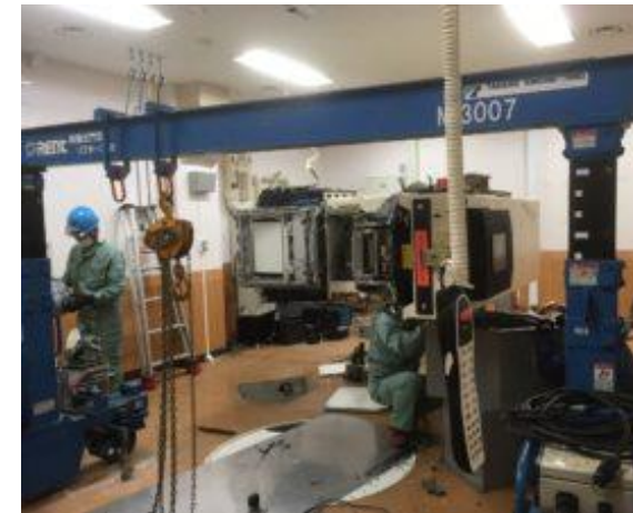
【屋内での解体作業状況】
