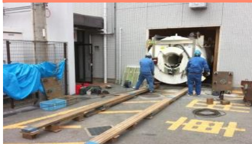
壁面切断・MRI撤去
