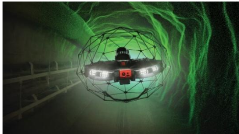
プラント点検
