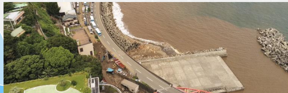
熱海市伊豆山土石流 災害支援 | 2021年7月
