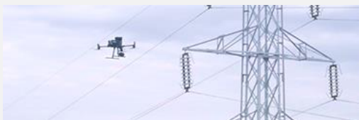
弛みのある送電線やケーブルを自動点検
