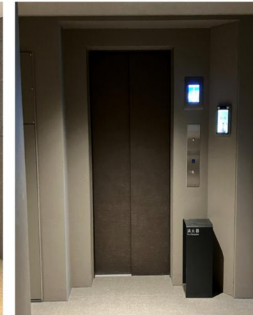
▲エレベーター
