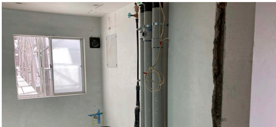
▲給排水管更新
