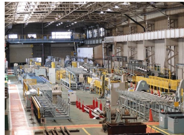
下関工場 BA管製造設備増強
