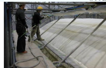
大手造船タンクメーカー殿でのLNG燃料タンク保冷工事の状況
