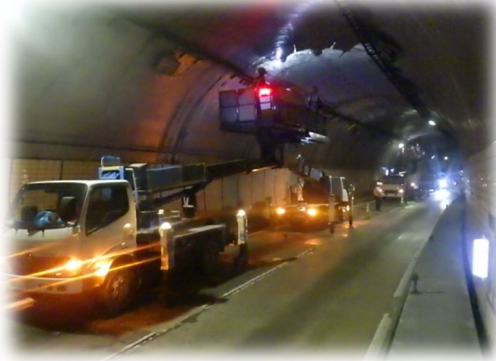
犬鳴トンネル補修工事
