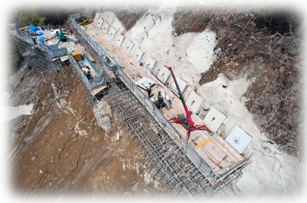
斜面对策工事（アンカー工）
