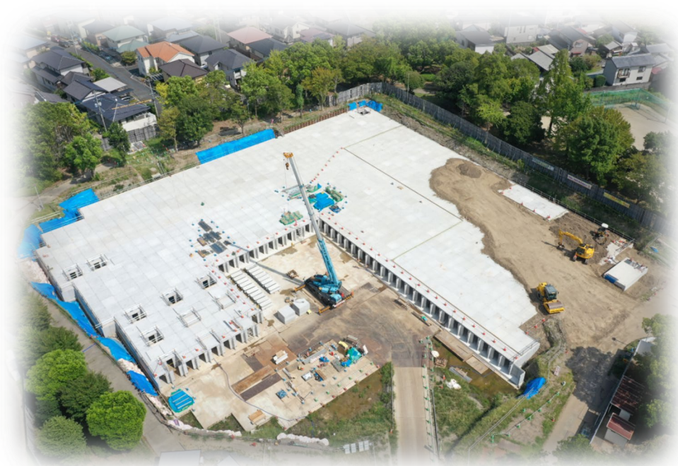
地下調整池築造工事（アクアポンドS型）
