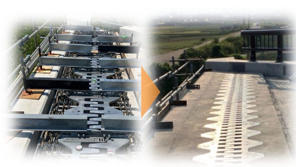
橋梁上部工工事（ダブルフィンガースーパージョイント）
