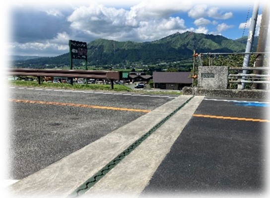
熊本高森線道路補修工事
