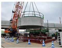
PCウェル工事 (材工一体受注)
