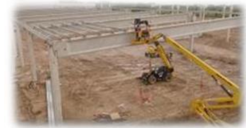
↑ 建屋工事の状況（アルゼンチン）
