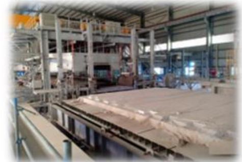
↑ 設備据付工事の状況（ベトナム）
