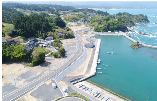
蔵内漁港海岸保全整備事業防潮堤整備
