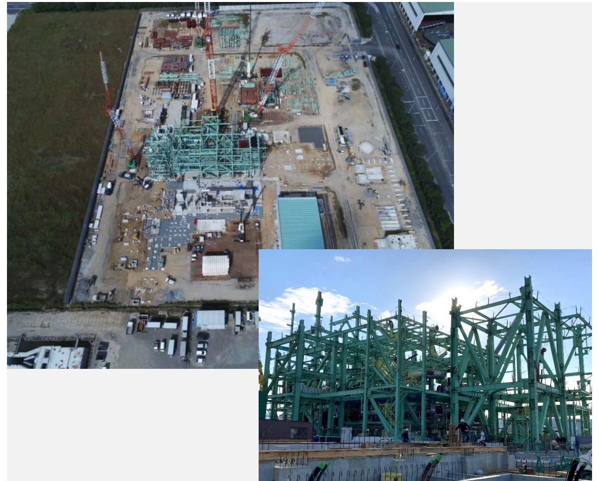
～「佐賀伊万里バイオマス発電所（仮称）」建設の様子～
