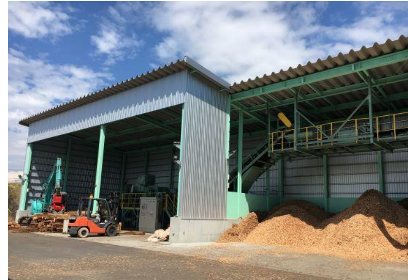
錦町2 MW木質バイオマス発電所 併設のチップ工場
