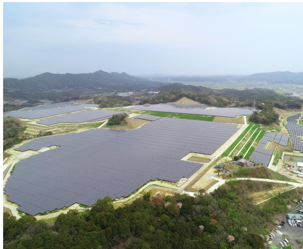
～福岡みやこメガソーラー南発電所が竣工しました～
