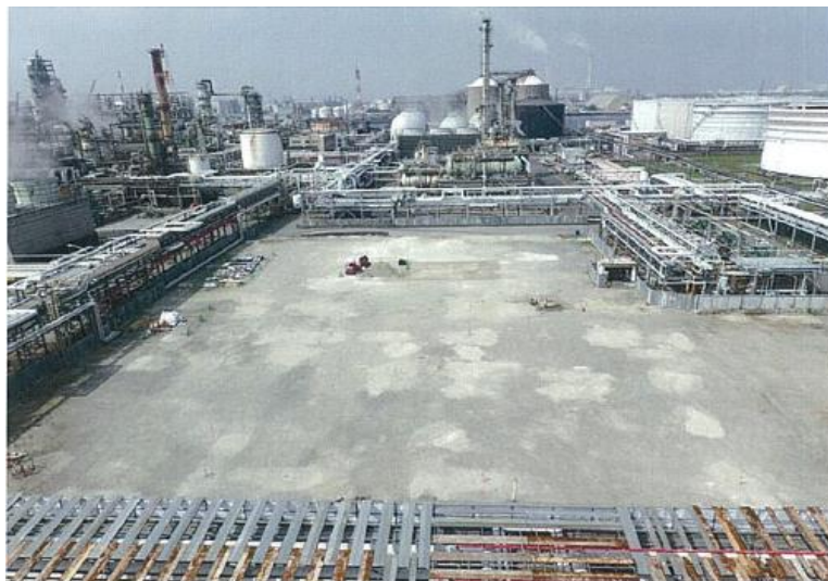
平成27年5月8日撮影(ASP-BTG建設工事全景)
