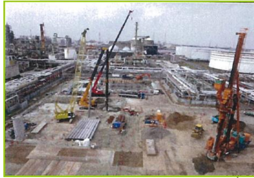
土建工事(H27.9末)
