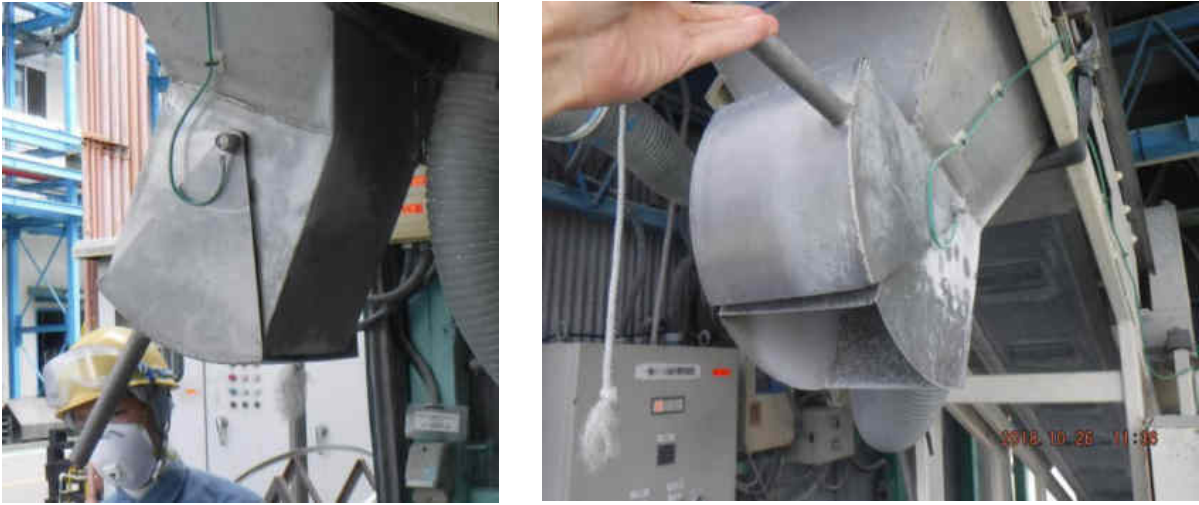
図 46 回転型スライド弁（類似品）
