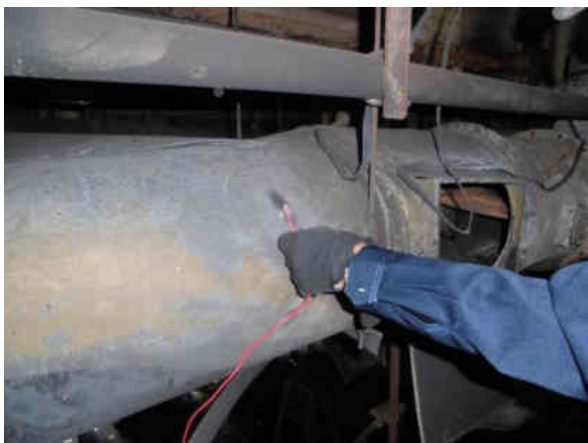
図 50 ダクトと接地極の間の抵抗測定の様況
