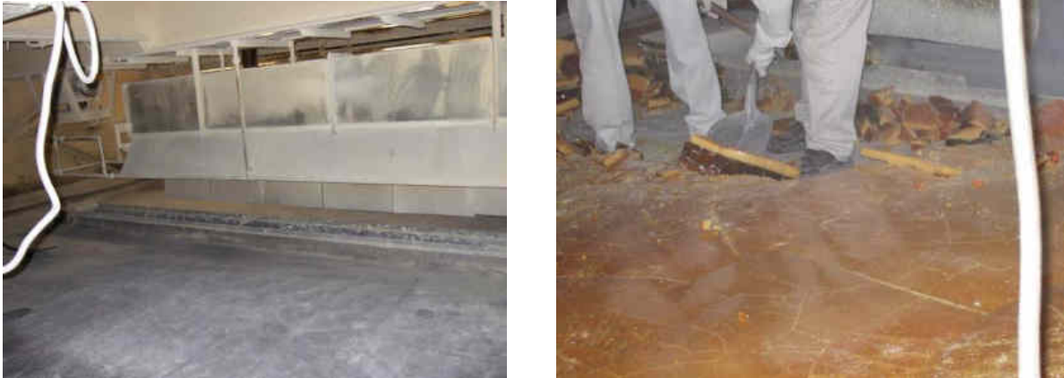
図 42 固化室内部の状況（北固化室，発災前）
