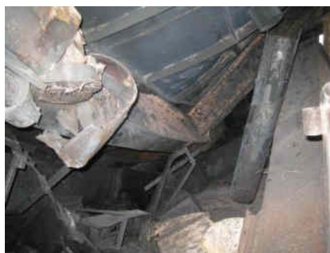
図 100 北固化室状況
