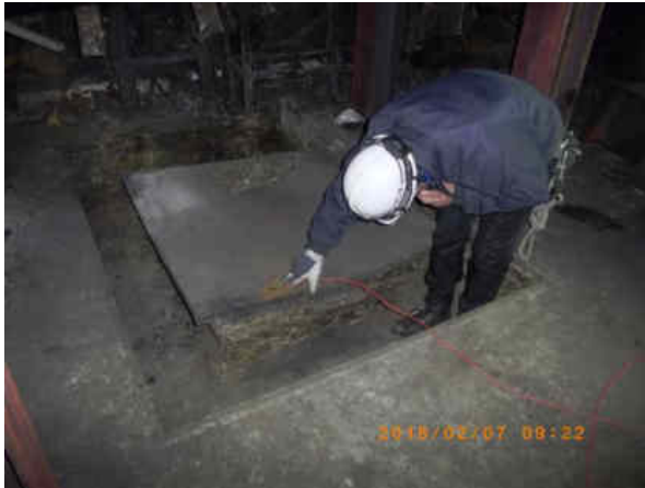
図 52 台秤と接地極の間の抵抗測定の状態
