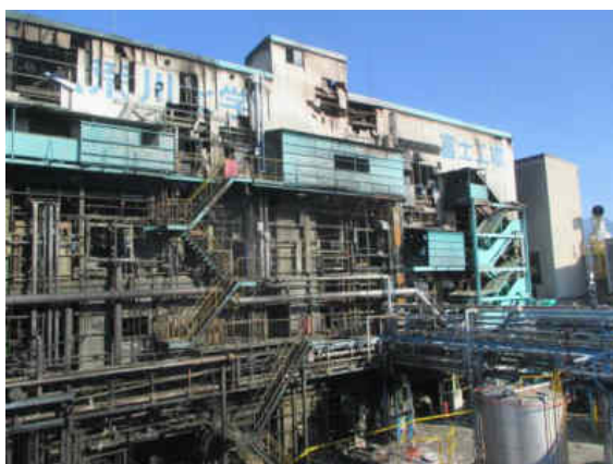
図 22 ①発災製造棟
