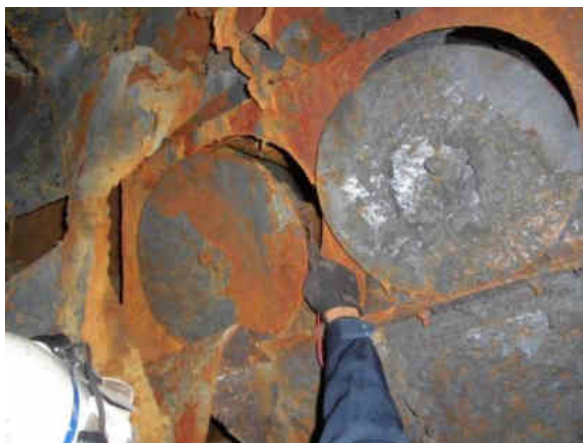
図 51 集じん機と接地極間の抵抗測定の様況
