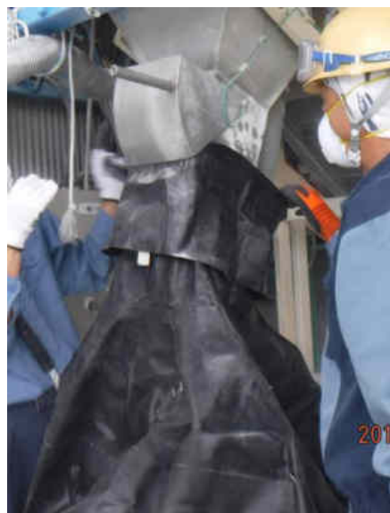
図 45 充填操作の状況（類似設備を使用して再現）
