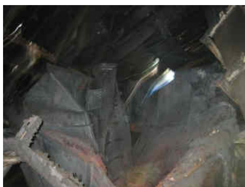
図 101 北固化室下のホッパー上部
