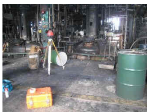
図 107 4階製造釜Cの沈降の監視状況
