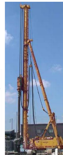
建築用薬剤を 使用した工事
