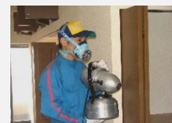
害虫防除施工
