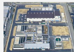
廃液処理工場
