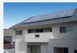
住宅用太陽光発電システム
