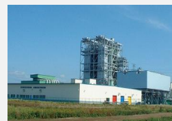
苫小牧発電所
