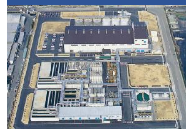
ひびき工場（廃液処理工場）
