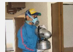
害虫防除施工
