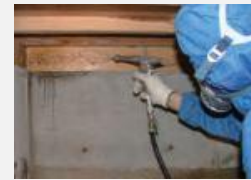
白蟻防除施工
