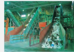
プラスチック資源開発工場
