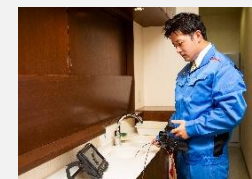
ビデオスコープによる水道管検査
