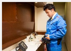
ビデオスコープによる水道管検査
