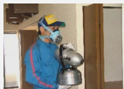
害虫防除施工
