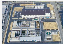
廃液処理工場
