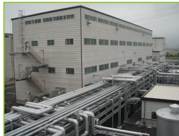
増設中のPPS樹脂工場(茨城県)
