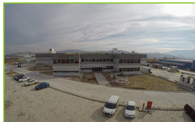
建設中のパッケージ用インキ工場(トルコ)
